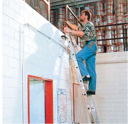
Bild 41: Eingehakte Anlegeleiter zum Übersteigen auf erhöhte Flächen mit Geländer als Haltemöglichkeit
